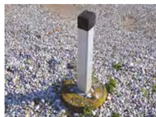
Realizzazione standard: installazione a terra in cemento
